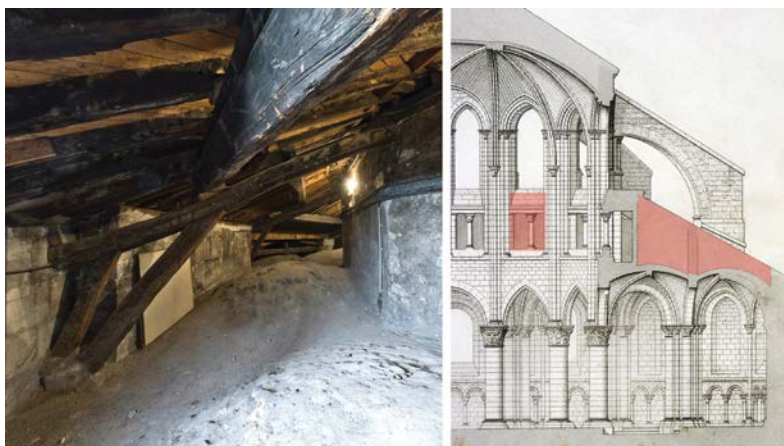
FIG. 6. – Ancienne abbatale de Saint-Germain-des-Prés : vue sur les comble du déambulatoire (à gauche ; cliché A. Tallon) et coupe sur le chevet (à droite ; A. Lenoir, Statistique monumentale de Paris , 3 vol., Paris, Imprimerie Impériale, 1867, vol. 1, planche 23).
