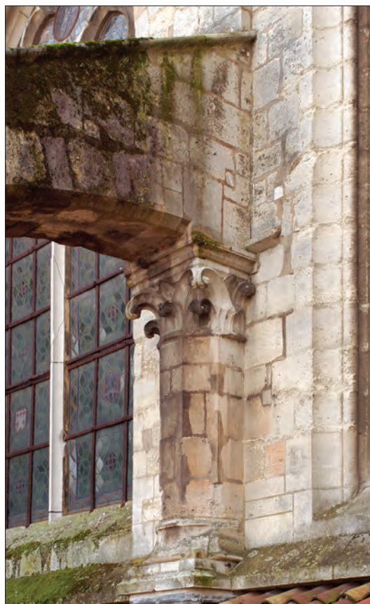
Figure 14. Sens, cathédrale, tête et contrefort polygonal de l'arc-boutant 12n, vu de l'ouest. Cliché Andrew Tallon.
