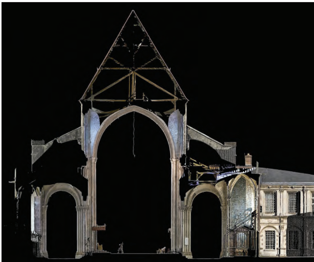
Figure 8. Sens, cathédrale, analyse laser, 2011, coupe 4. Image Andrew Tallon.
