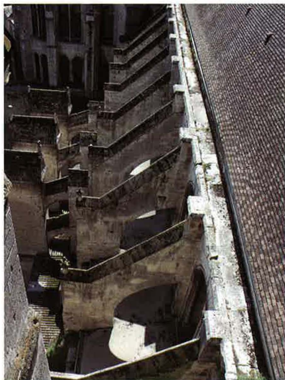
Fig. 4. Noyon, cathédrale. Vue des arcs-boutants du flanc nord de la nef. Cl. Arnaud Timbert.
