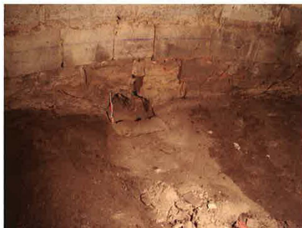
Fig. 5. Noyon, cathédrale. Vue d'une cavité ménagée au creux des voûtains, à l'extrados des voûtes de la nef. Cl. Arnaud Timbert.
