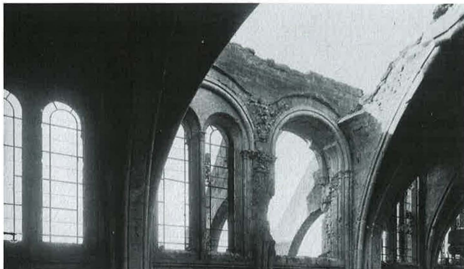
Fig. 7. Noyon, cathédrale. Vue d'une cavité de la nef avant restauration. Cl. A. Collin n° 26118.
