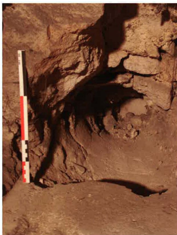
Fig. 6. Noyon, cathédrale. Vue intérieure d'une cavité ménagée au creux des voûtains, à l'extrados des voûtes de la nef. Cl. Arnaud Timbert.
