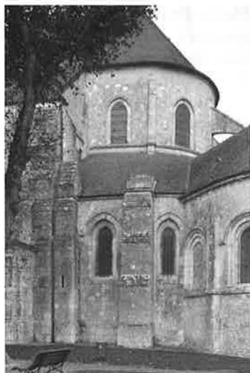
Figure 18. Étampes, Saint-Martin, flanc sud du chevet, 2006.
