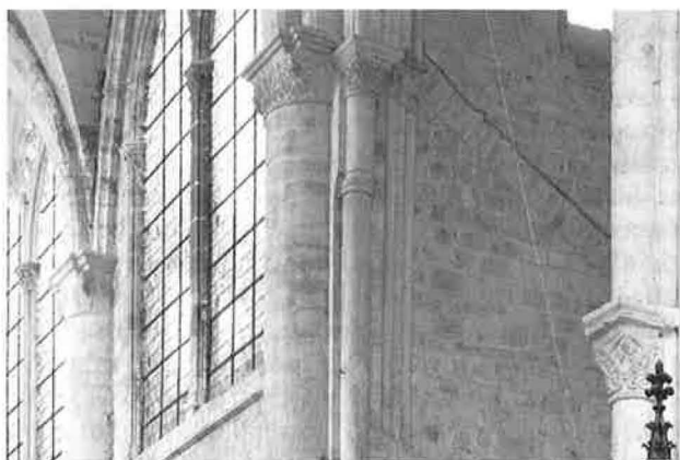
Figure 10. Étampes, Notre-Dame, pierres rampantes, côté nord.
