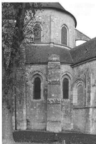
Figure 15. Étampes, Saint-Martin, flanc sud du chevet.
