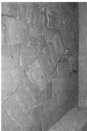
Figure 11. Étampes, Notre-Dame, détail des pierres rampantes, prise sous le toit du bas-côté nord.
