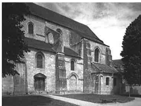
Figure 14. Étampes, Saint-Martin, flanc sud de la nef.
