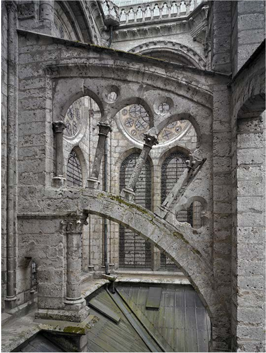
Fig. 7 : Chartres, cathédrale. Arc-boutant du transept sud, face est. © A. Tallon.
