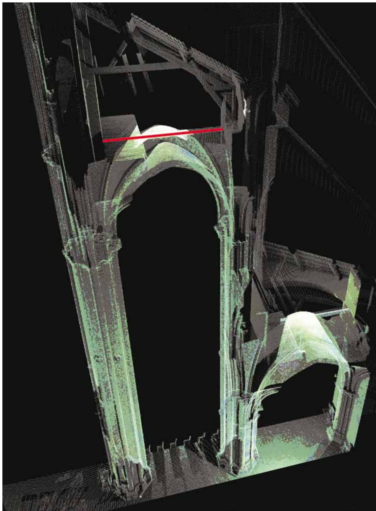
Fig. 9 - Bourges, cathédrale, relevé laser, vue axonométrique montrant la position des tirants en fer.
